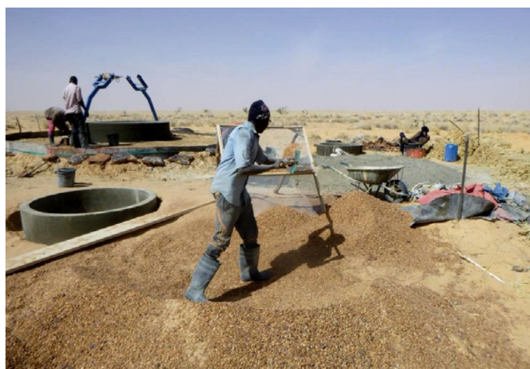
↑ Construction d'un puits pastoral en plein désert.
